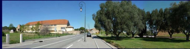
L'entrée Est du Village de Roquebrune avec sa Cave Coopérative le 8 avril 2012 ...
