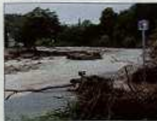
La mise en œuvre du projet devrait permettre d'atténuer très sensiblement les effets néfastes des crues. (Photos DR, S.L.)
